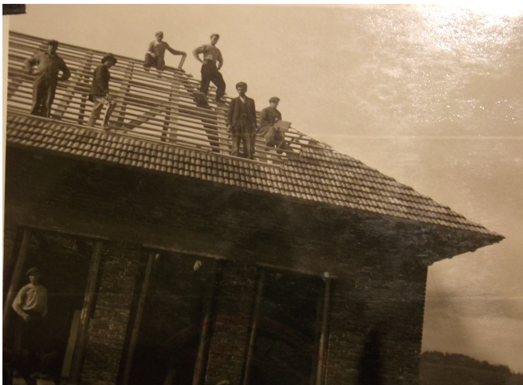
Krycie dachu - listopad 1938
