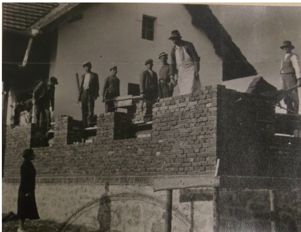
Rozbudowa szkoły październik 1938
